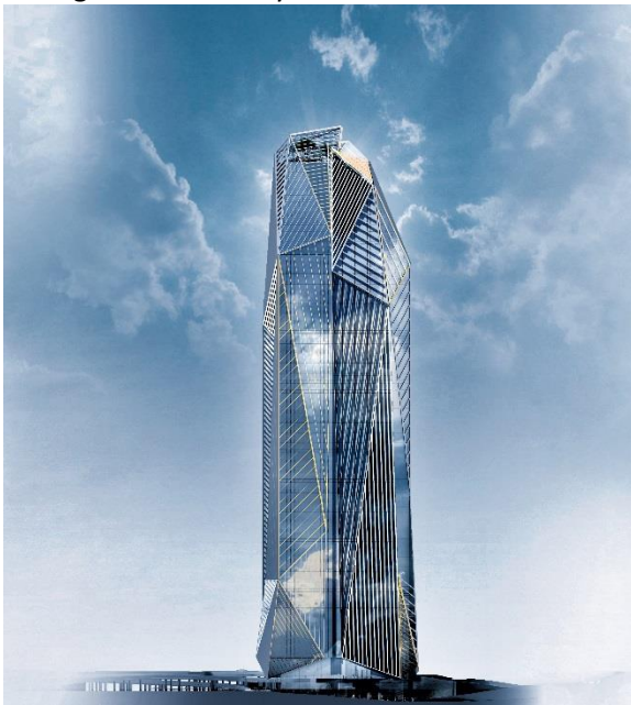
Façade HEKLA - Crédit : Ateliers Jean Nouvel
